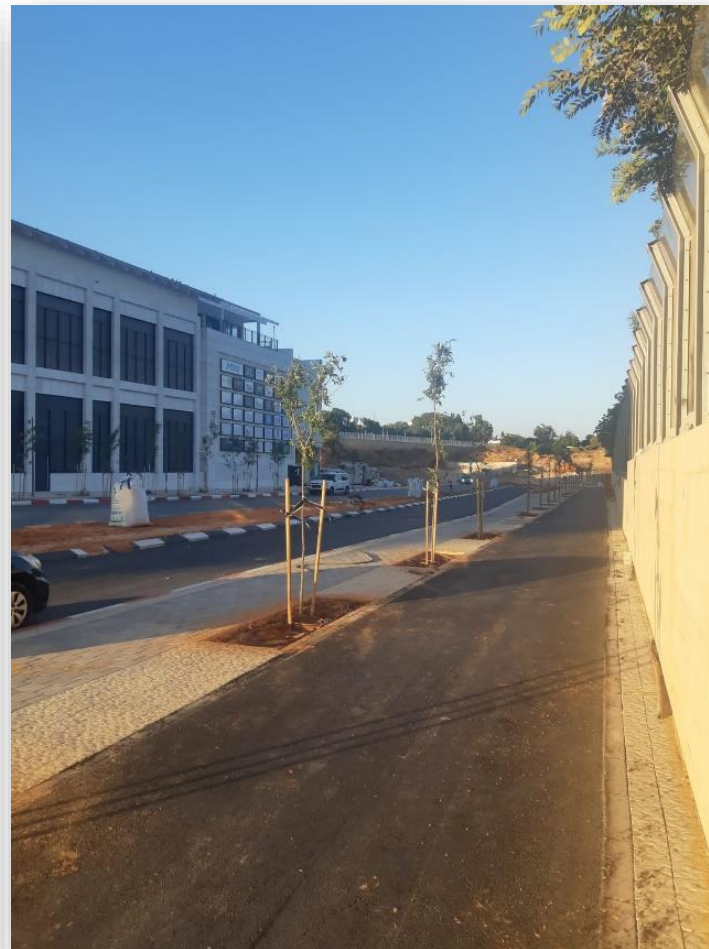
מתחם 1201 - קיר אקוסטי, ביצוע מדרכות, שביל אופניים וכביש אספלט
