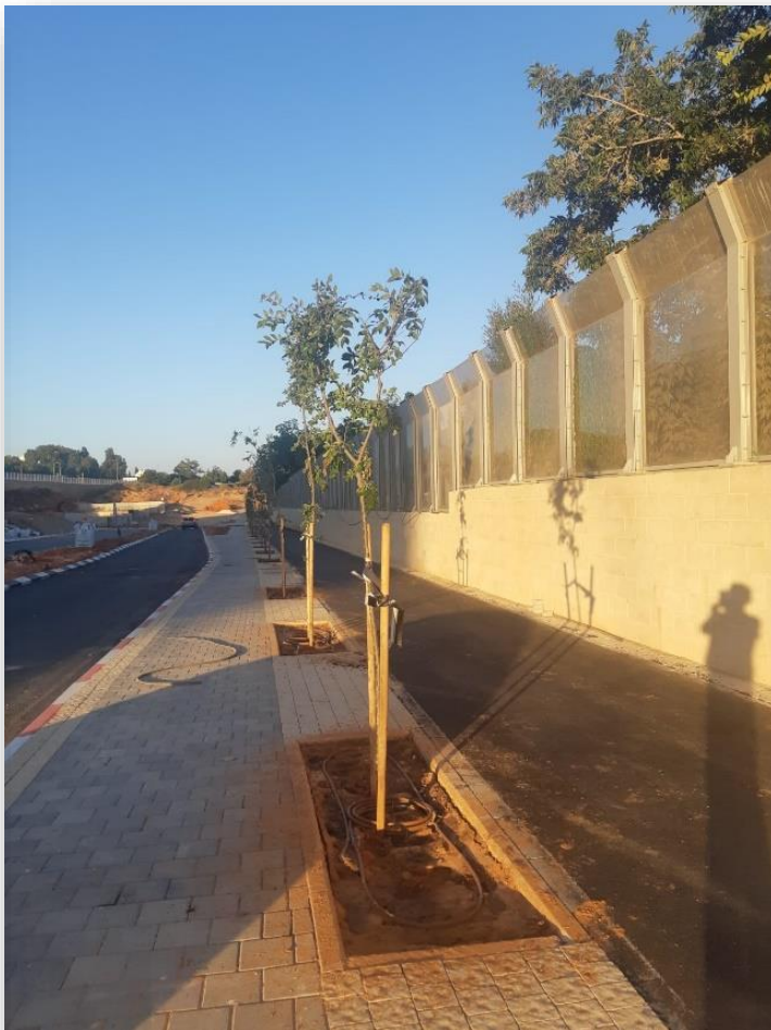
מתחם 1201 - קיר אקוסטי, ביצוע מדרכות, שביל אופניים וכביש אספלט
