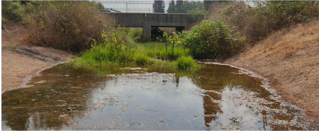
איור 40: תמונה עליונה- מבט במורד היציאה מהמעביר מעל ברחוב קדם. תמונה תחתונה- מבט במעלה היציאה ממעביר המים.
