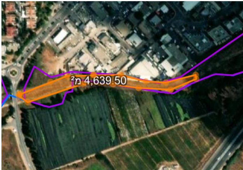
אתר 31 נחל הדס תיכון. מפגעי פסולת בנין, גרוטאות, צמחיה פולשת, זרימת ביוב.
